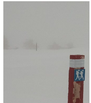
Kuvat 12 – 15. Vanhat reittimerkinnot uusittiin. Reittimerkinnot uusittiin kesän 2023 aikana. Reittipaaluihin asennettiin R2 luokan sääolosuhteita kestävä kirkas heijastinteippi ja alumiininen retkeilyreitit opastekyltti. Uudet reittimerkinnot erottuvat hyvin myös pimeällä otsa- ja/tai taskulampun valossa ja talvisissa olosuhteissa.
