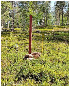
Kuvat 12 – 15. Vanhat reittimerkinnot uusittiin. Reittimerkinnot uusittiin kesän 2023 aikana. Reittipaaluihin asennettiin R2 luokan sääolosuhteita kestävä kirkas heijastinteippi ja alumiininen retkeilyreitit opastekyltti. Uudet reittimerkinnot erottuvat hyvin myös pimeällä otsa- ja/tai taskulampun valossa ja talvisissa olosuhteissa.
