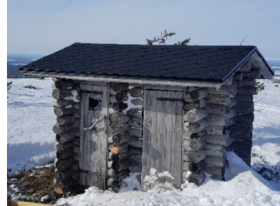
Kuvat 5 – 7. Päivätuvan katon eristeet, päivätupa ja liiteri-huussirakennuksen uusittu katto. Päivätupa rakennettiin kesän 2022 aikana, liiteri-huussirakennus nostettiin uusille perustuskiville ja katto sekä tulipaikka uusittiin kesän 2023 aikana.
