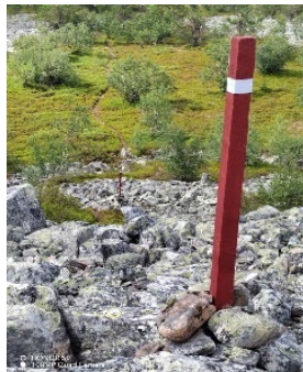
Kuvat 12 – 15. Vanhat reittimerkinnot uusittiin. Reittimerkinnot uusittiin kesän 2023 aikana. Reittipaaluihin asennettiin R2 luokan sääolosuhteita kestävä kirkas heijastinteippi ja alumiininen retkeilyreitit opastekyltti. Uudet reittimerkinnot erottuvat hyvin myös pimeällä otsa- ja/tai taskulampun valossa ja talvisissa olosuhteissa.
