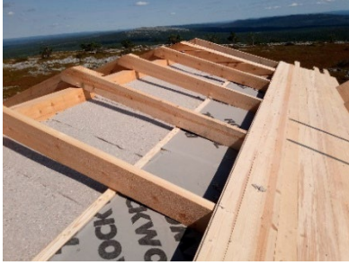
Kuvat 5 – 7. Päivätuvan katon eristeet, päivätupa ja liiteri-huussirakennuksen uusittu katto. Päivätupa rakennettiin kesän 2022 aikana, liiteri-huussirakennus nostettiin uusille perustuskiville ja katto sekä tulipaikka uusittiin kesän 2023 aikana.
